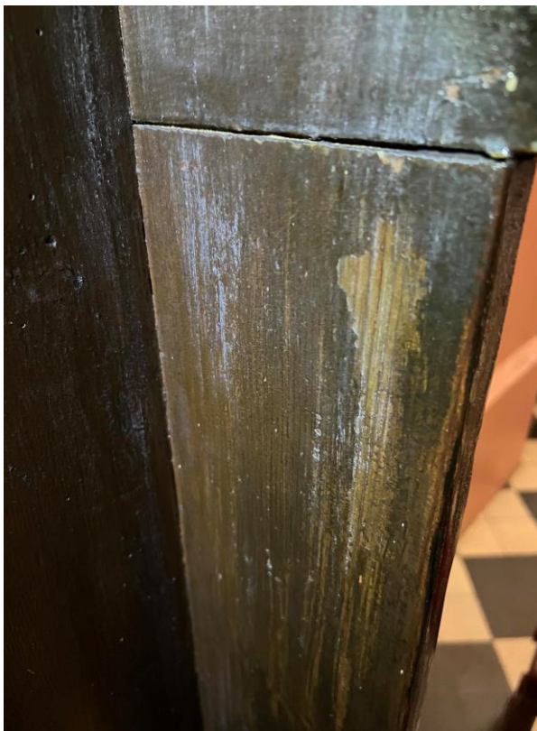
Fot.14. Ubytek warstwy lakieru – konfesjonał duży.
