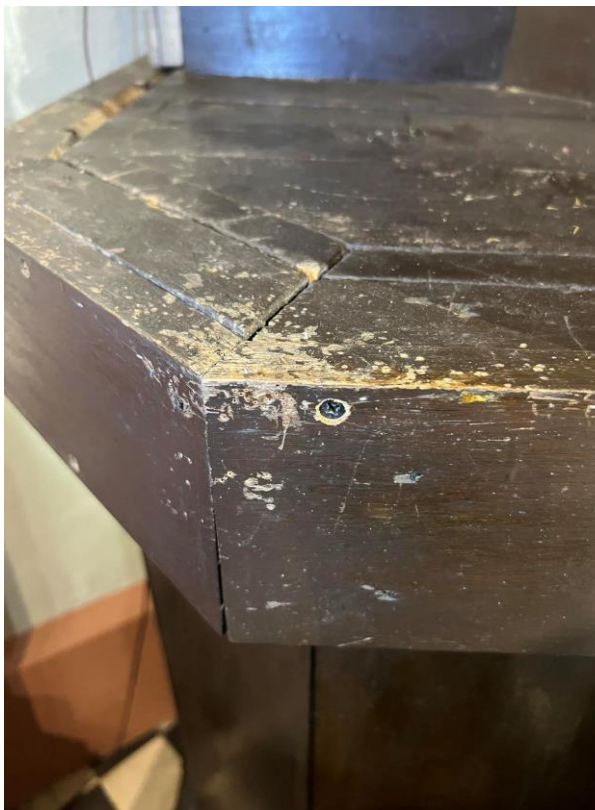
Fot.5. Uszkodzenia mechaniczne – ołtarz główny.
