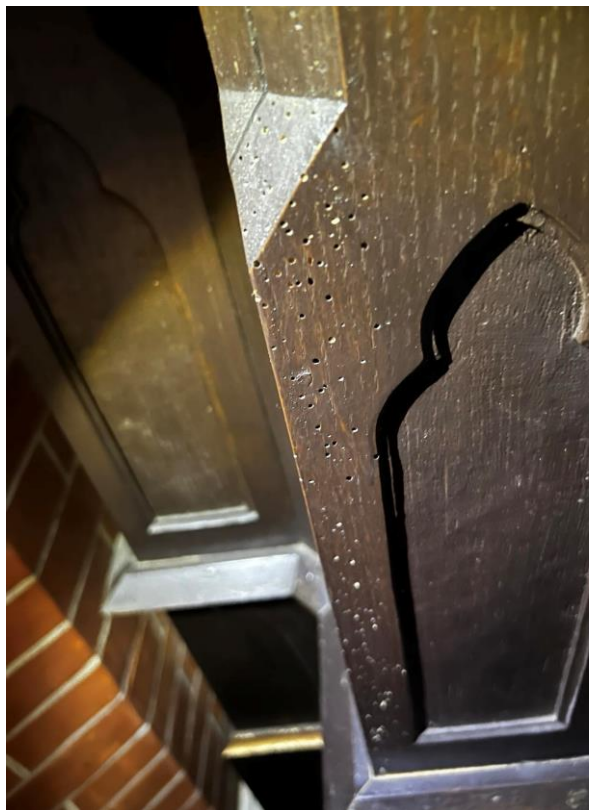
Fot.6. Otwory wylotowe po drewnojadach – ołtarz główny.
